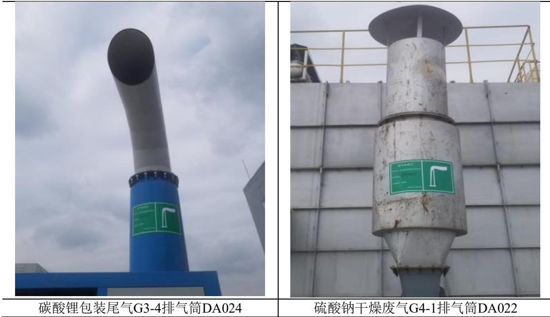
图 4-1厂区废气排气筒现状照片
