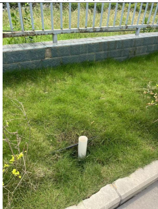
厂区东侧场界处地下水监控井
