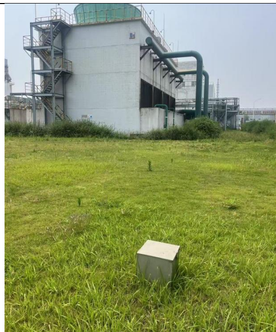
厂区中部地下水监控井
