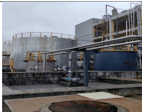
硫酸储罐区围堰
