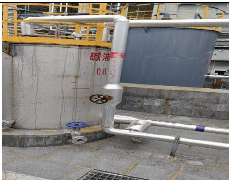
硫酸储罐区围堰
