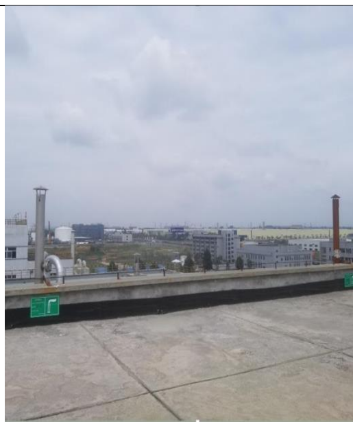
碳酸锂干燥尾气G3-1排气筒DA018、碳酸锂包装尾气G3-2排气筒DA019
